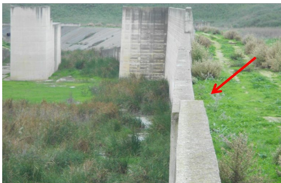
Figura 12.4: Vasca di dissipazione – Iniziale perdita di allineamento tra le elevazioni – Novembre 2012
