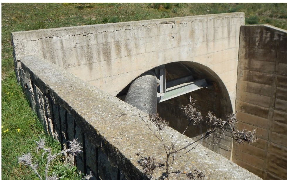
Figura 5.4: Vasca di dissipazione – Degrado del calcestruzzo
