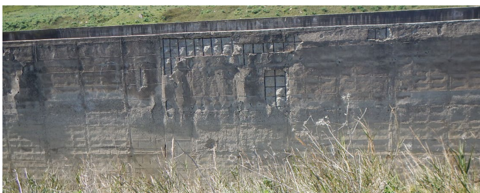
Figura 5.5: Vasca di dissipazione – Degrado del calcestruzzo
