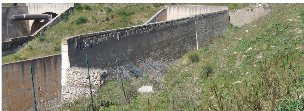
Figura 5.6: Vasca di dissipazione – Degrado del calcestruzzo e muro crollato
