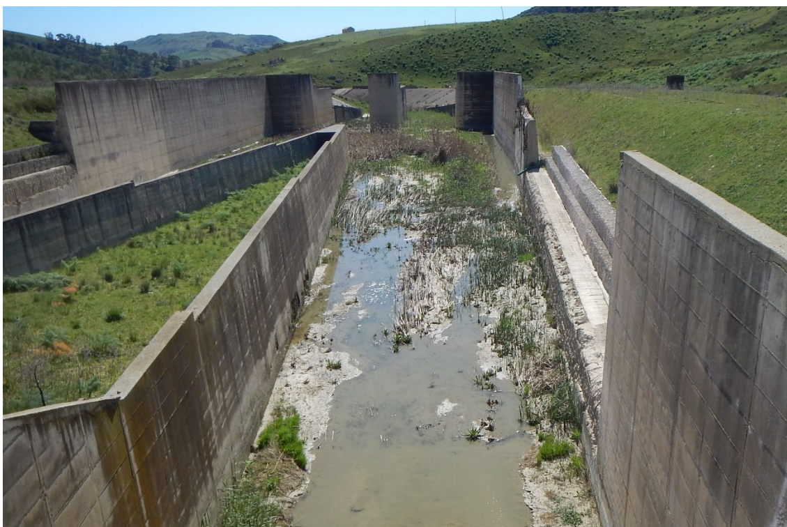
Figura 5.1: Vasca di dissipazione – Sbocco della galleria dello scarico di fondo – Porzioni di muro crollate e interrimento generalizzato della vasca
