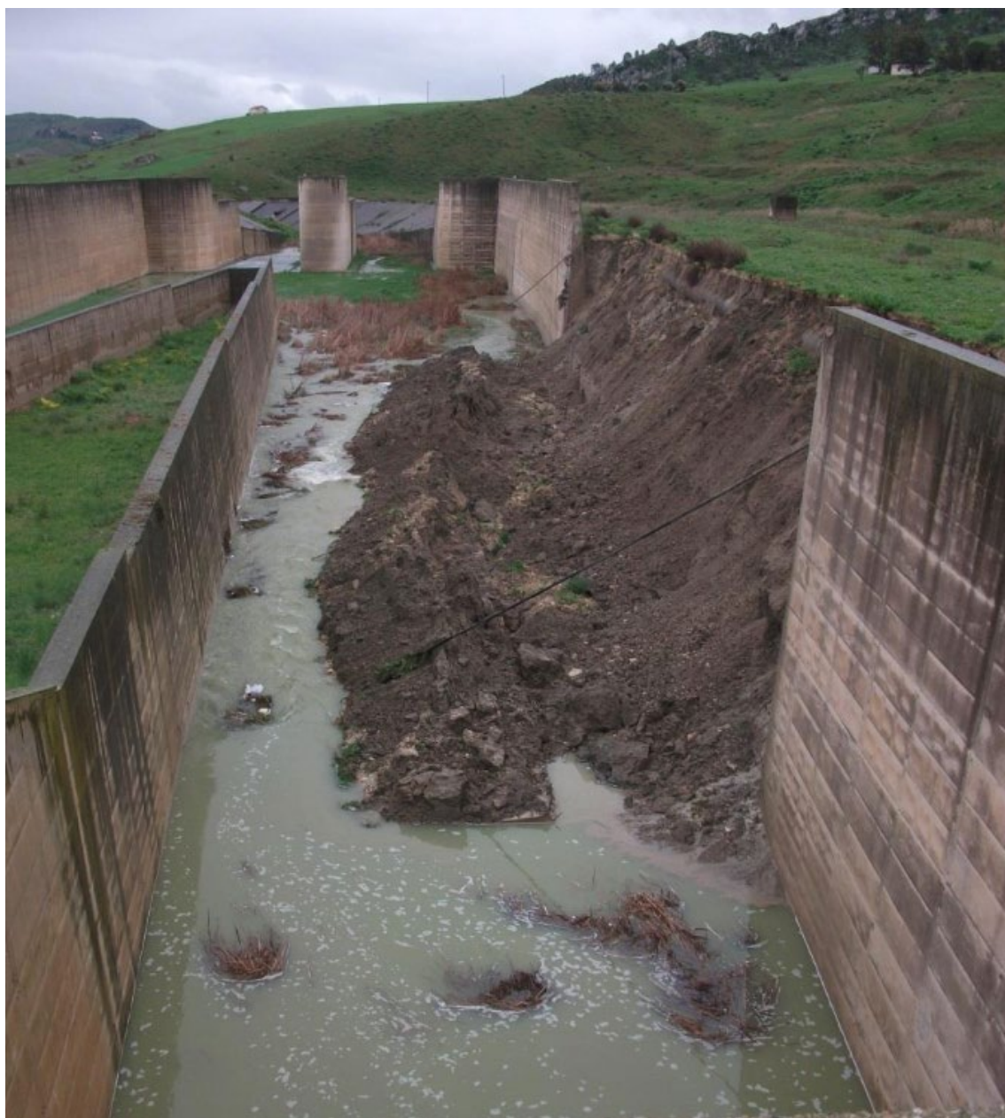
Figura 12.5: Vasca di dissipazione – Crollo muro andatore in destra idraulica – 14 marzo 2013
